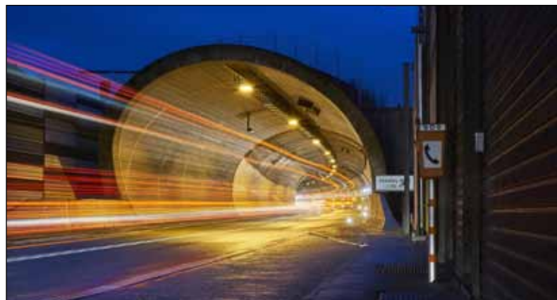
Drogowy tunel to wygoda. Ale i źródło zanieczyszczeń. Można je filtrować, by zdrowie okolicznych mieszkańców nie było zagrożone.
