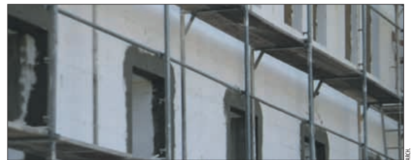
Docieplający domy będą mogli liczyć na pokaźne ulgi podatkowe, jeśli podjęte działania termomodernizacyjne będą prowadzić na podstawie audytu.
